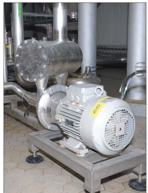
Abb. 2: Um die in den Tank eingebrachte CIP-Flüssigkeit abzuführen, werden meistens Kreiselpumpen als Seitenkanalpumpen (Abb. li.) oder spezielle Kreiselpumpen, die in der Lage sind eine gewisse Menge Luft zu tolerieren (Abb. re.), eingesetzt.
