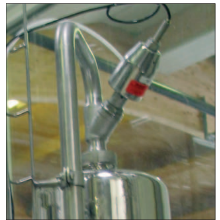
Abb. 4: Die Gullyventile (mit pneumatischem Antrieb und Syphon), sollten ebenso wie die in DN 25 ausgeführten Entlüftungen der Filtergehäuse, z.B. mit Blenden ausgerüstet sein, um den Volumenstrom zu reduzieren.
