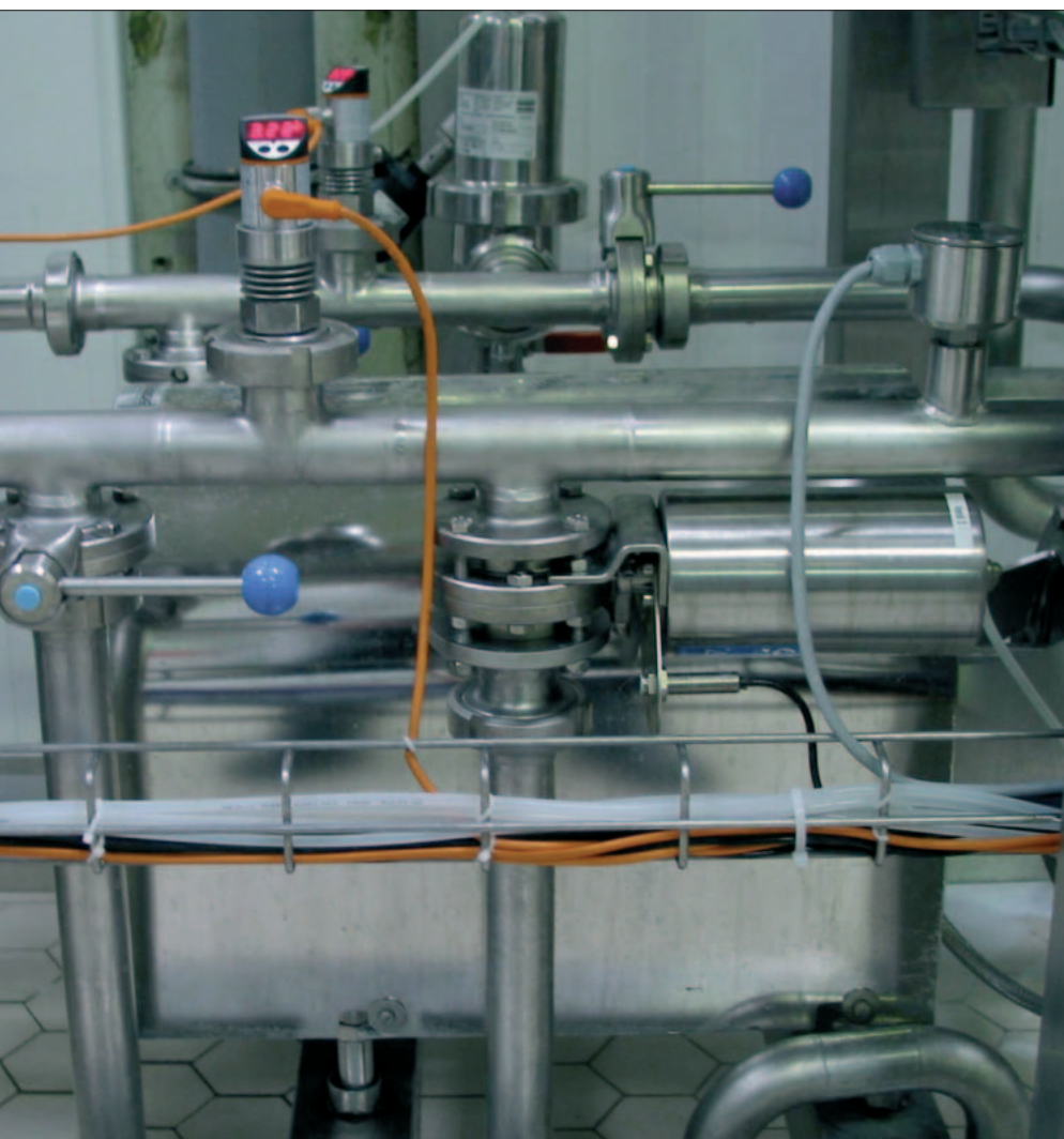
Abb. 1: Der Einsatz von Verschraubungen und Ventilen in Zwischenflanschausführung scheint vollkommen wahllos erfolgt zu sein. Es ist unerklärlich, warum z. B. in einem Gullyabgang ein Ventil in Zwischenflanschausführung gewählt wurde. (Quelle: Kalinowski)
