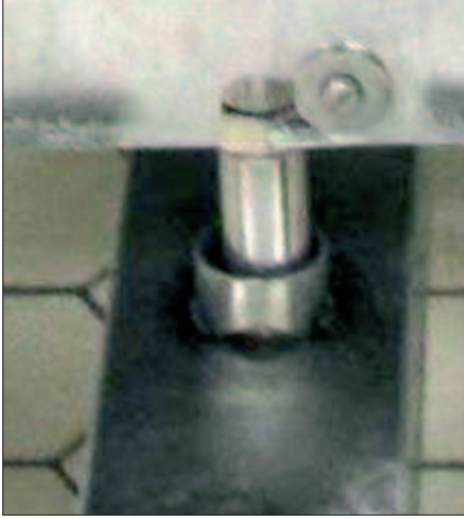
Abb. 3: Die Pumpe ist mit höhenverstellbaren Füßen, wie man es für die Aufstellung auf dem Fußboden üblicherweise vorsieht, versehen. Statt die Füße heraus zu schrauben und den Motorfuß auf dem Gestell zu verschrauben, wurde eine ziemlich skurril anmutende Montage gewählt, Rohrabchnitte wurden auf das Gestell geheftet und die Pumpenfüße hier hinein gestellt.
