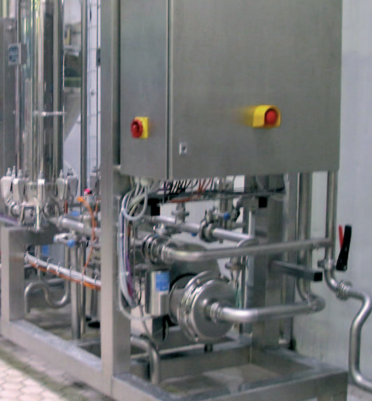
Abb. 2: Die Gleitringdichtung dieser Pumpe kann nur gewechselt werden, wenn zahlreiche Rohrleitungen und Ventile demontiert werden.
