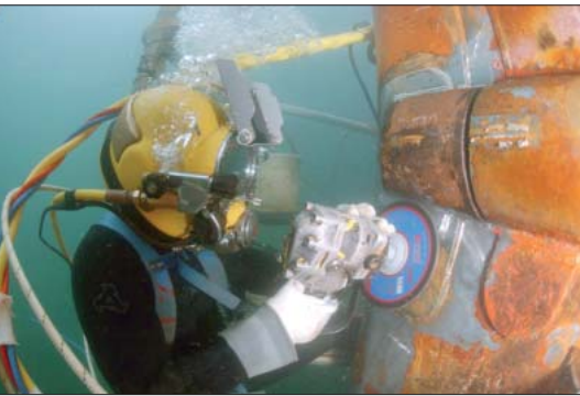
Abb. 2: Siloeinfahrhosen sind zur Inspektion der Tankinnenwand nur bedingt geeignet.
