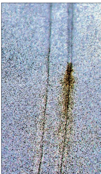
Abb. 9: Ausführung CC, Schweißnahtkorrosion
