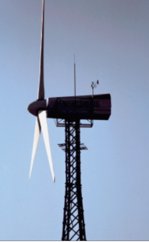
Gittermast mit Enercon, 1991, 50 kW Nennleistung, inzwischen durch leistungsstärkere Anlage mit Betonmast ersetzt.
