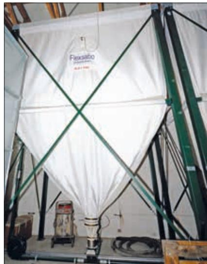
*Abb. 1: Textilsilo und Rohrkettenförderer gehören in der Brauerei zu den Exoten; die 10,4 t beziehen sich auf Schwergetreide mit 0,8 t/m<sup>3</sup>, das heißt mit 7,3 t Malz ist dieses voll.*
