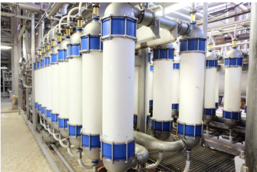
Filteranlage – Technische Abnutzung fast linear
