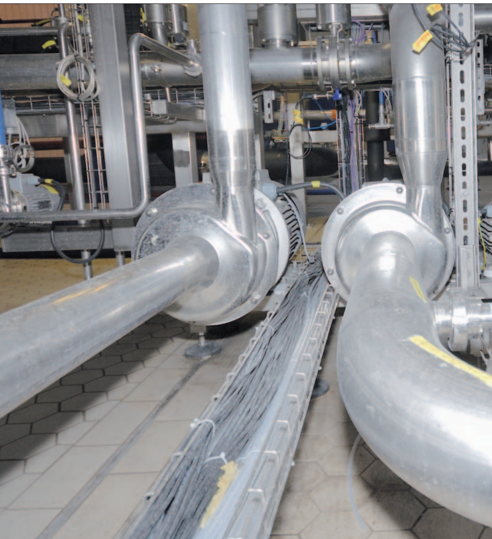
Abb. 1: Eingeschweißte Kreiselpumpen
