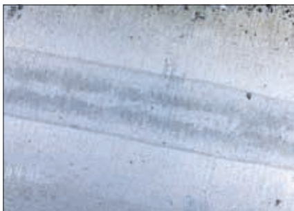
Die Längsnaht wirkt optisch fehlerfrei, ist aber viel zu breit und der Schweißzusatzwerkstoff ist nicht sachgerecht.
