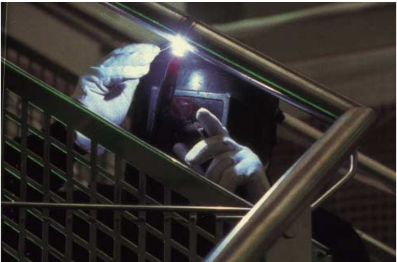
Bild 14: WIG-Schweißen auf der Baustelle
